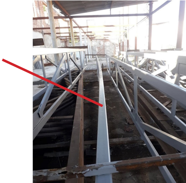
ნახ.3. დეფექტების წარმოქმნა კონსტრუქციის ელემენტებში რეკომენდაციების დარღვევის შედეგად.
