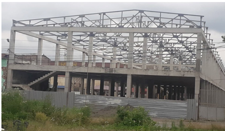
ნახ.4. ქ.ქუთაისში წერეთლის გამ., #186-ში მშენებარე სავაჭრო ცენტრის სახურავი.
