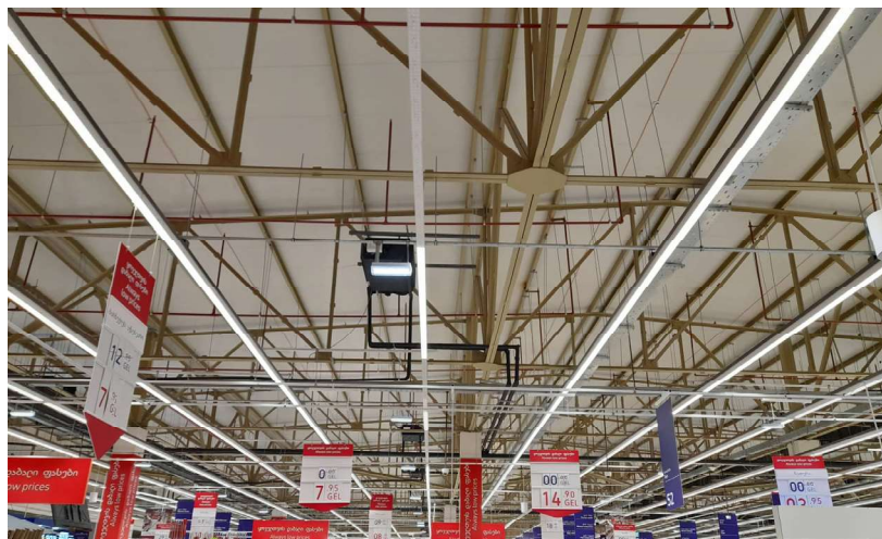
ნახ.1. ქ.ქუთაისში სავაჭრო ცენტრ „კარფურის“ გადახურვის კონსტრუქცია.
